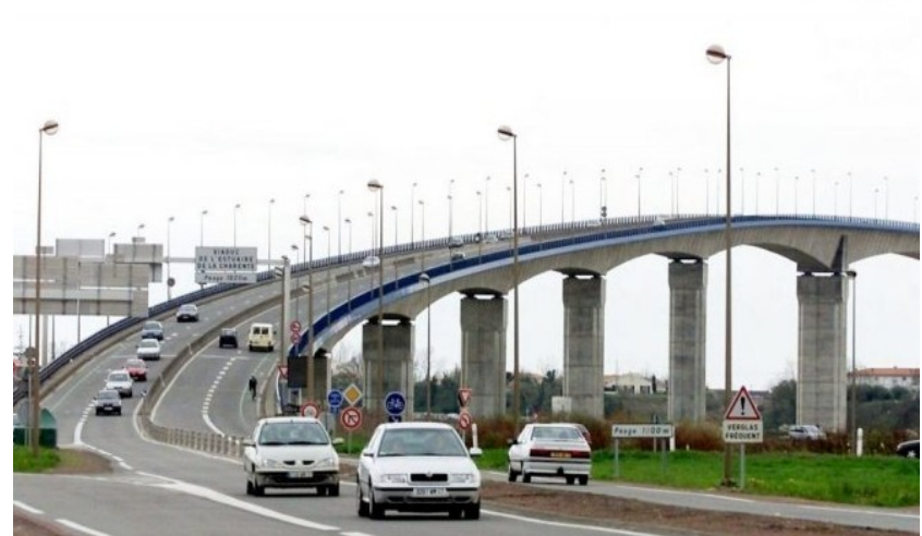
Pont à poutre
