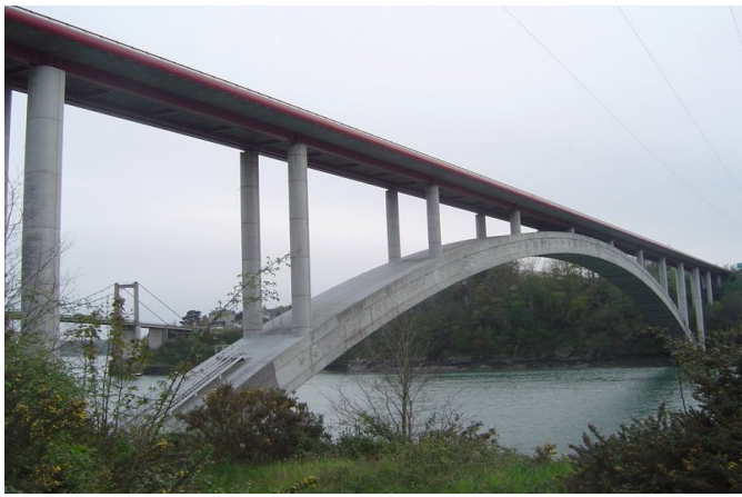
Pont en arc
